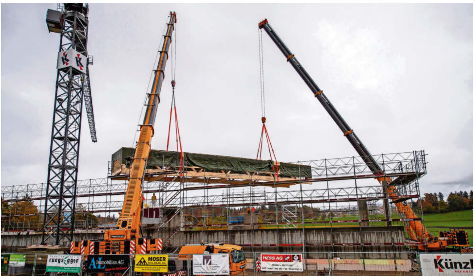
Am Montagmorgen wurde der Hauptdachträger der neuen Gossauer Turnhalle installiert. Foto: Seraina Boner
